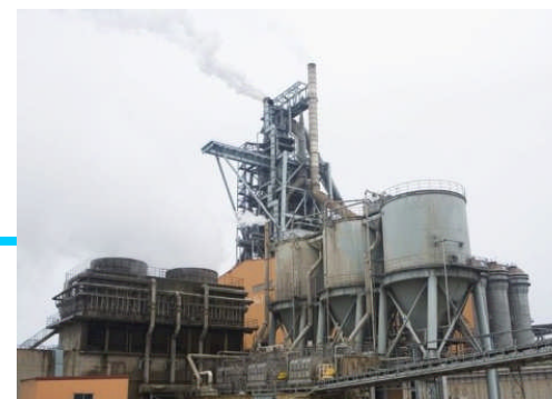
▲水砕スラグ製造設備
